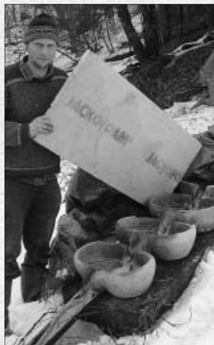
Flowformer på Solborg. Denne luftetrappen er i drift hele året, men har blitt dekket til de to siste vintrene for å undersøke om dette bidrar til mindre luktavdrift. Foto: A. Tufto.
