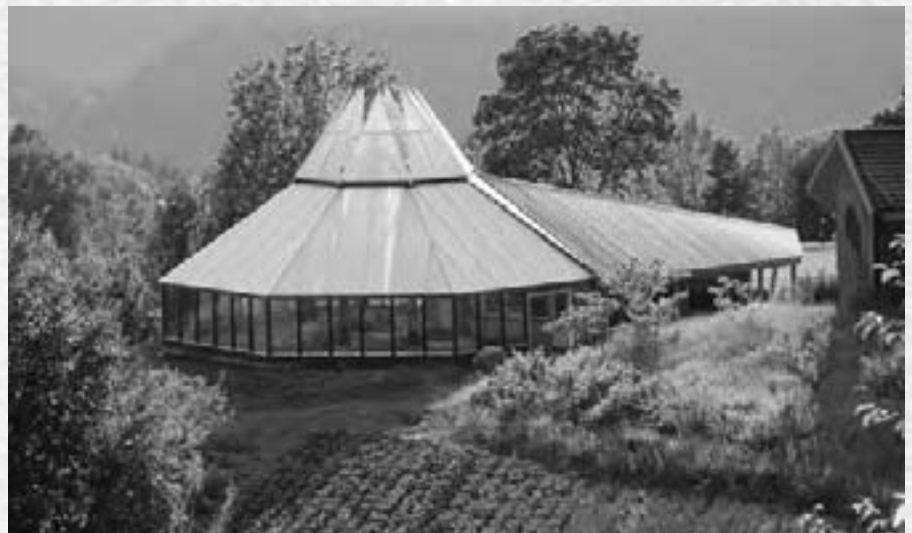
Det nye drivhuset på Solborg.
